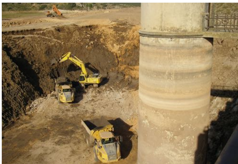
-Figura 13- Obras de dragado en julio de 2007. Fotografía: M. J. Pereda.
