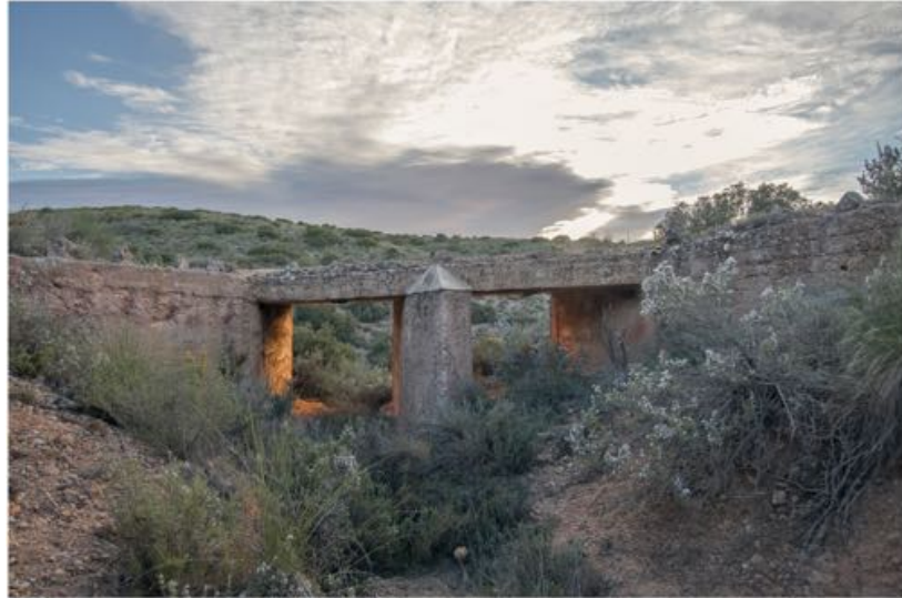
-Figura 16- El Puente Rusia. Fotografía: Paulino Ruano
