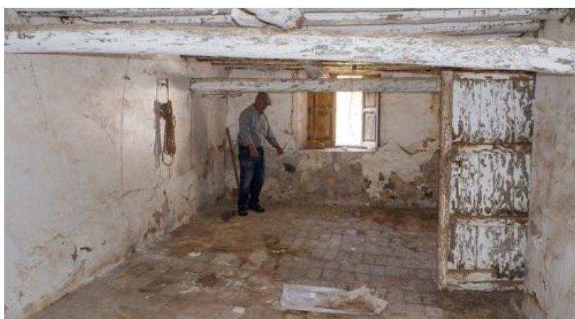
-Figura 22- Lagar. Se aprecia la inclinación del suelo hacia el desagüe. Fotografía: Carlos Hernán- dez Baeza
