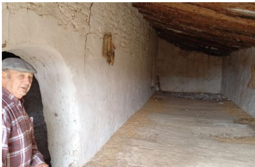
-Figura 27- Pavimento de argamasa del pajar alto. Fotografía: Joaquín Fco. García Sáez
