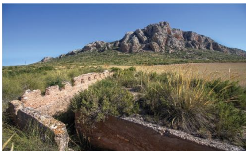
Vista de trinchera en codo, de obra y con aspilleras. Fotografía: Paulino Ruano
