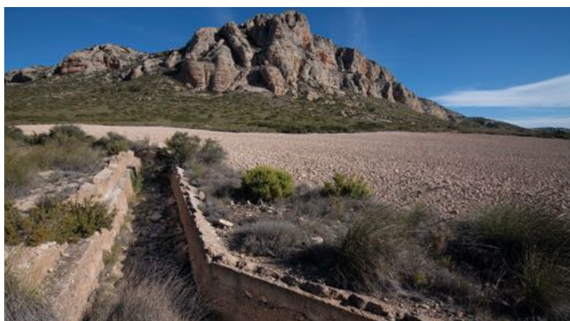
-Figura 2- Trinchera fortificada con muros de hormigón y parapeto. Fotografía: Paulino Ruano
