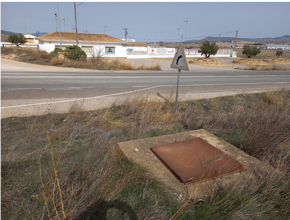
- Figura 37 - Registros de sifones situados a ambos lados de la Circunvalación. Autor: J. F. García Sáez.
