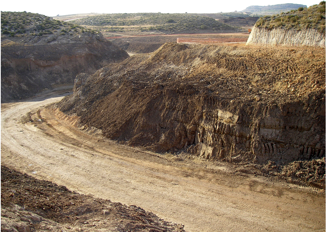
- Figura 58 - Dragado parcial del embalse. Fotografía: M. J. Pereda Hernández.
