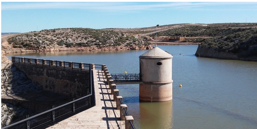
Agua embalsada en el Pantano de Almansa de la que emerge la torre de servicio de limpieza del fondo (1921)
