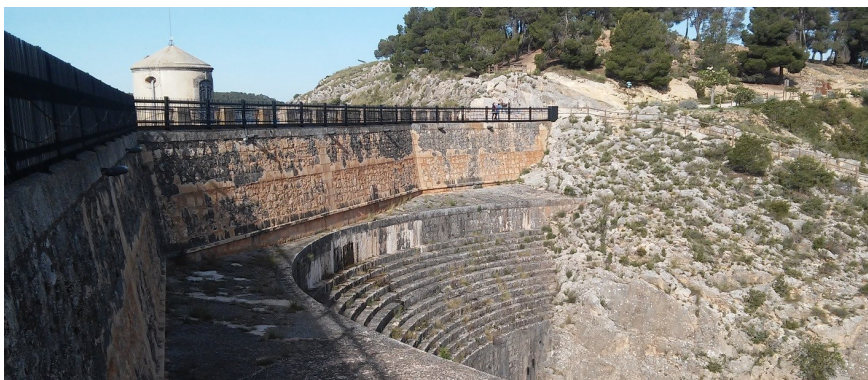
La presa de arco de gravedad fue construida entre 1584-1586 y alcanzó su altura actual con una ampliación en el siglo XVIII
