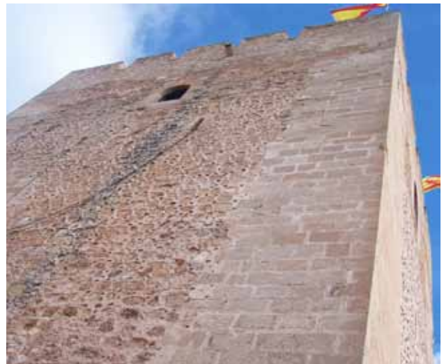
Figura 034. Revestimiento en el Castillo de Sax.
