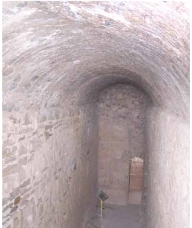
Figura 021. Interior del Ala Sur del Castillo. Muros portantes y bóvedas de mampostería
