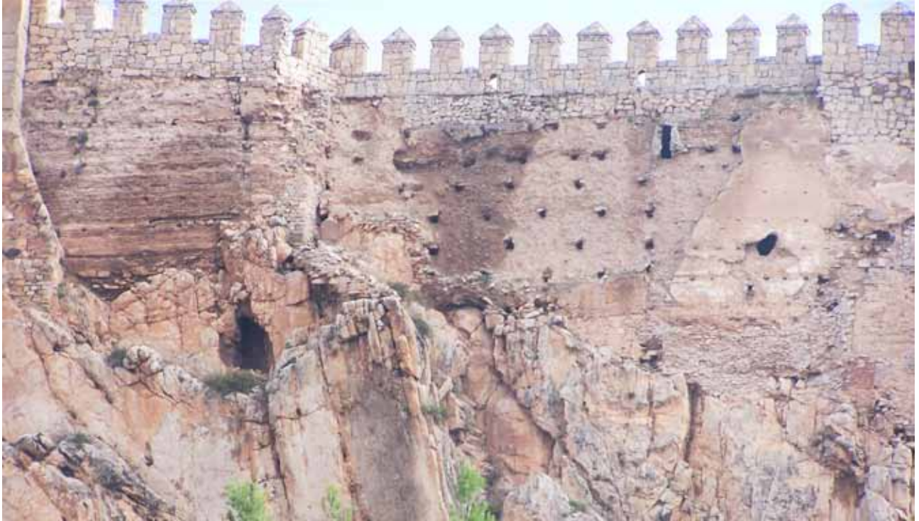
Figura 025. Mechinales de rollizos en el Ala Sur.
