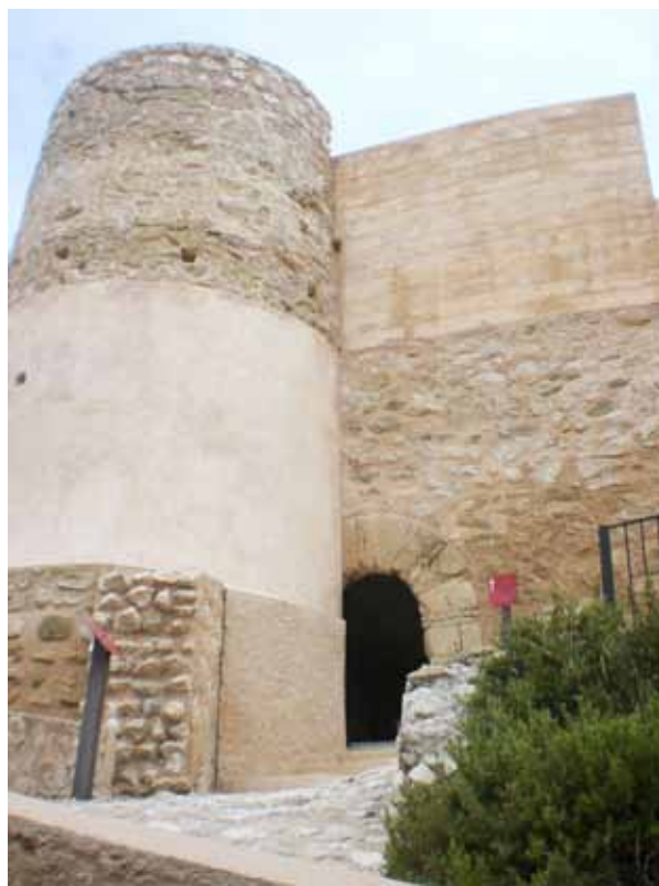
Figura 131. Refuerzo de la esquina de la entrada en el castillo de Biar. Autor: Miguel Jover Cerdá.
