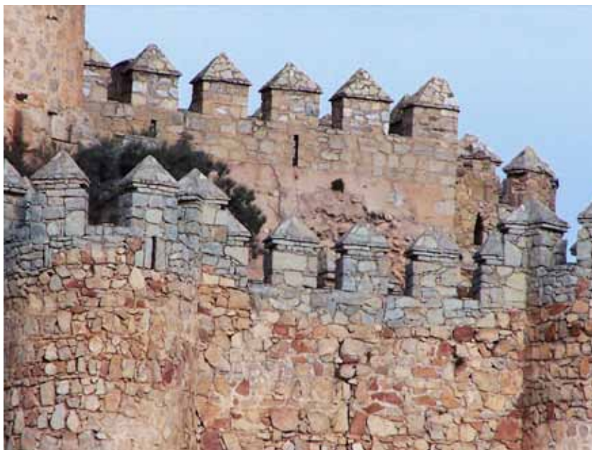
Figura 035. Construcción de mampostería (merlones) del siglo XX sobre paño del siglo XV.
