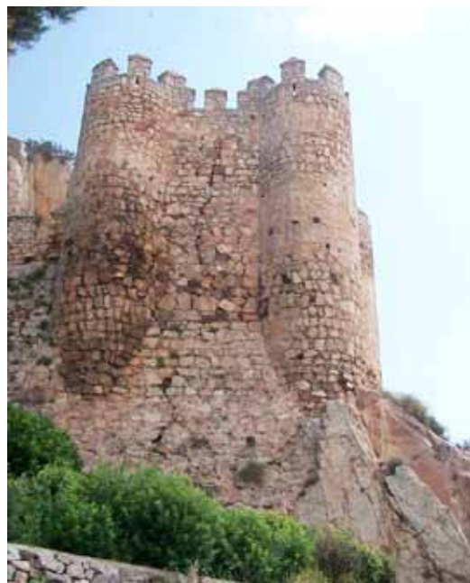
Figura 028. Construcción de mampostería del siglo XV: Nueva construcción. Barbacana.
