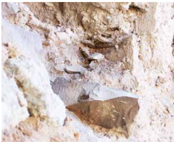
Figura 096. Aguja de tapial en el paño del ala sur dispuesta en la orientación norte-sur.
