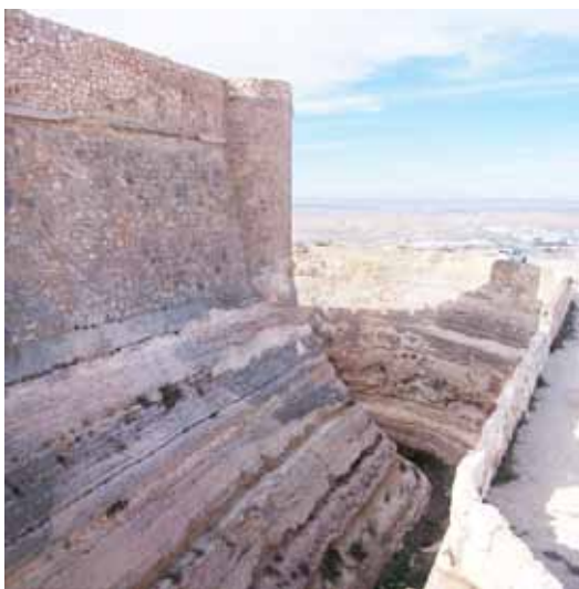
Figura 125. Foso del castillo de Chinchilla con contraescarpa.
