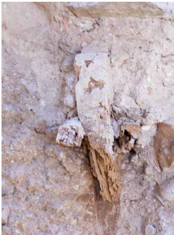
Figura 018. Resto de clavo de madera y media aguja en la masa del tapial.
