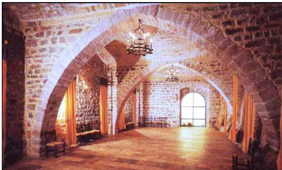
Figura 060. Espacios abovedados soportados por arcos diafragmáticos en el monasterio del Puig de Valencia.
