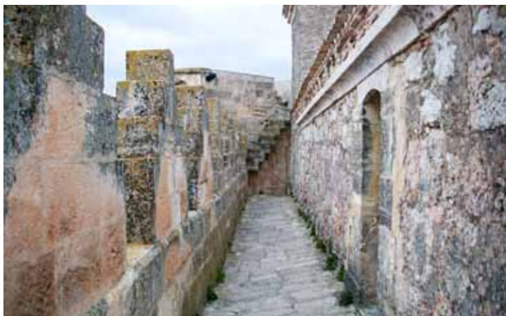
Figura 064. Adarve o paso de ronda enmarcado por muro almenado exterior y nave con cubierta inclinada interior en el Castillo de Belmonte.
