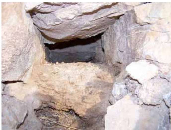
Figura 024. Mechinal donde estuvo alojado un rollizo soporte del andamiaje y/o encofrado.
