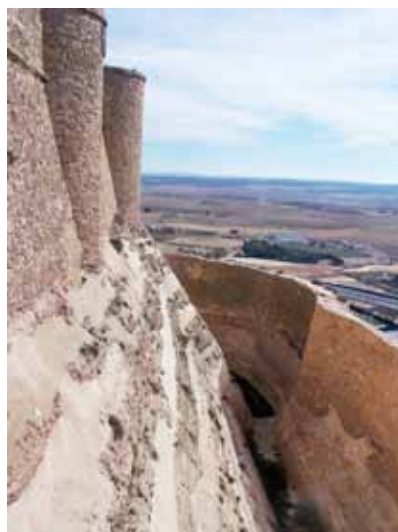
Figura 126. Foso del castillo de Chinchilla con contraescarpa artificial.
