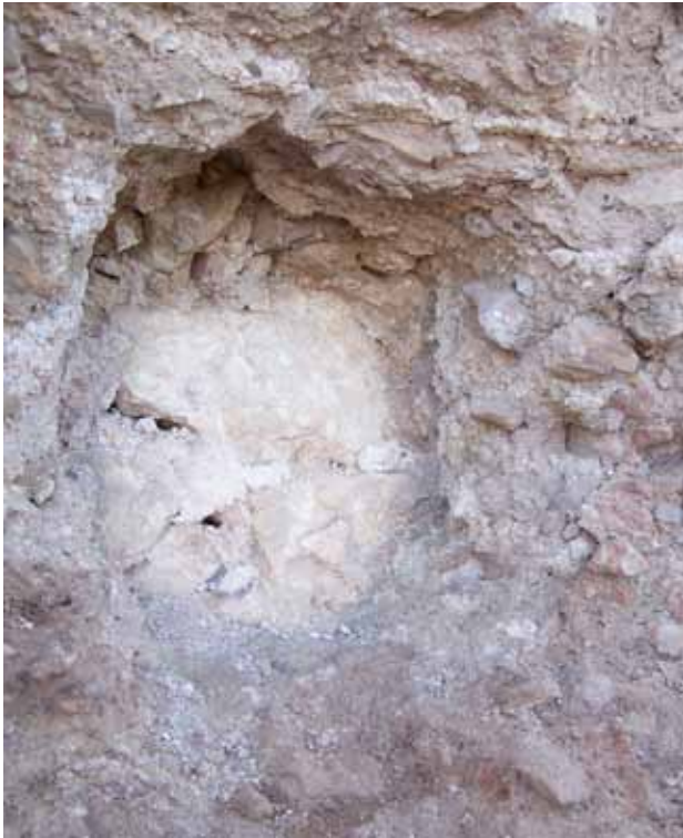
Figura 020. Detalle del estado del muro de tapial con pérdida de masa, trasdosado por muro de mampostería
