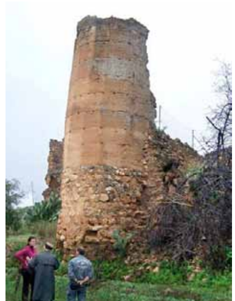
Figura 026. Torre poligonal de Tapial del Castillo de Socovos.
