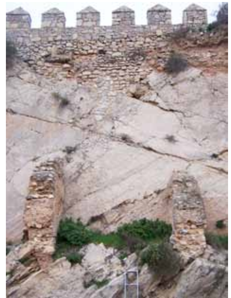
Figura 055. Restos de arranques de muros e impronta y arranque de bóveda.
