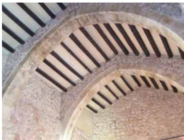
Figura 059. Nave con arcos diafragmáticos en el Castillo de Alarcón.
