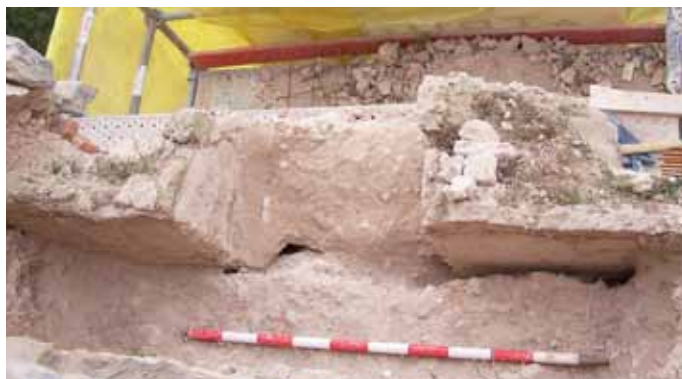
Figura 097. Restos de almenas inmersas en el actual paño sur del recinto superior.
