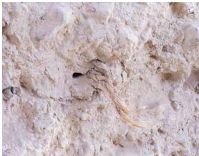
Figura 019. Cuerda de esparto en la masa del tapial.
