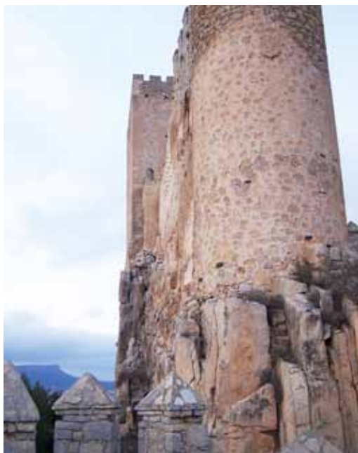
Figura 027. Construcción de mampostería del siglo XV: Refuerzo del extremo del Ala Sur.
