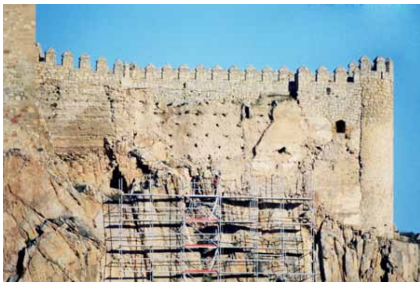
El Lienzo T1-T10 antes de su restauración, en el momento de instalación del andamio necesario para acceder a él.
