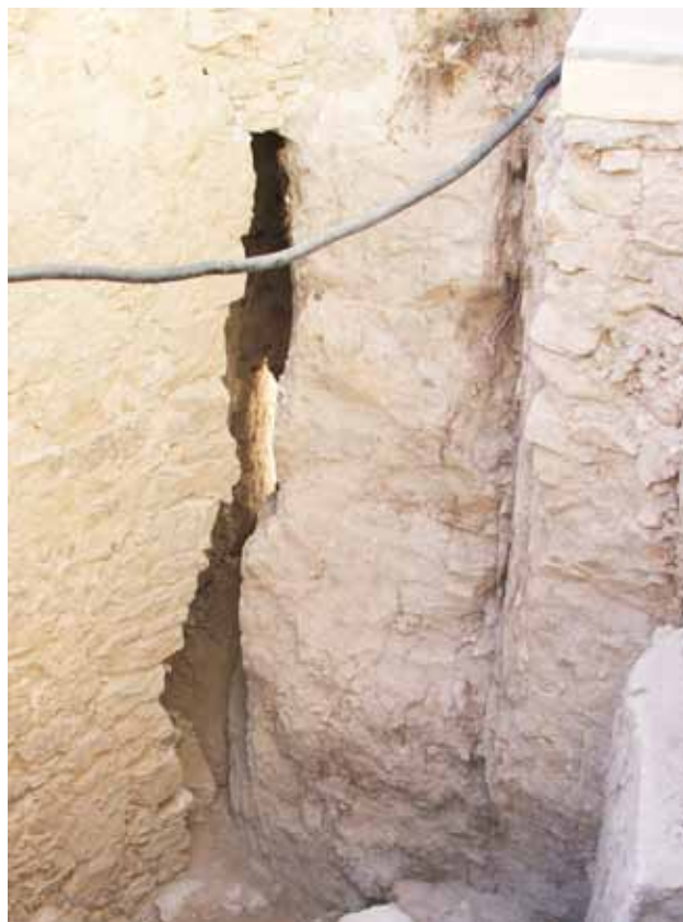
La grieta detectada por la parte interior de la torre T5 se correspondía con la que ya se observaba por su cara exterior.
