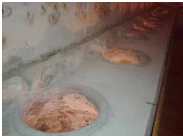
Figura 7: Sistema de llenado de tinajas con canalillos de obra. (Fotografía: José Ramón Martínez).
