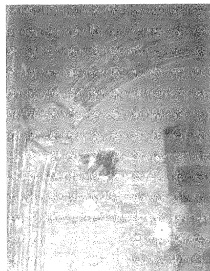
Restos del enjarje y arco de la bóveda de nervios de la base del campanario, del lado del evangelio.
