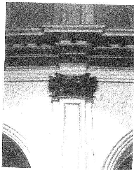
Detalle de la decoración de las antas o pilastras de las arcadas. Se utiliza la superposición de retropilastra-pilastra, de orden corintio, que recibe el entablamento constituido por architrahe escalonado, friso corrido decorado con estucos y cornisa, bajo la que se desarrolla una sucesión de dentículos y ménsulas.
