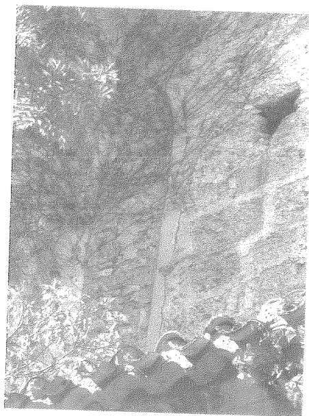
Primitivo vano lateral oculto, en parte, por el recrecimiento de un estribo intermedio, algo más delgado que los seis más gruesos del proyecto inicial.
