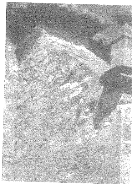
Obra de mampostería en un estribo del muro lateral sur o del lado del evangelio.
