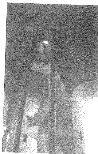
Escalera de acceso al remate de la torre, que se abre paso a través de la bóveda baída con la que se cierra el cuerpo de campanas. Los tubos de hierro son parte de las modificaciones de la restauración de 1986-1987.
