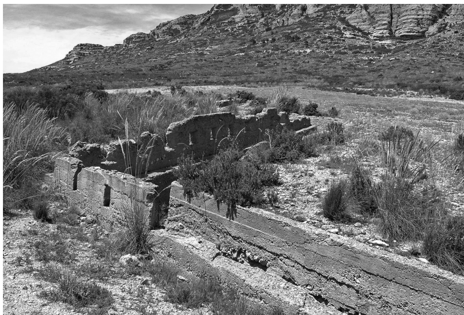
Trinchera fortificada de la zona de El Mugrón, con un parapeto exterior con troneras.
