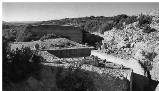
En el búnker 14, por hallarse inconcluso, podemos ver la estructura del edificio internamente así como el proceso de construcción que se emplea.
