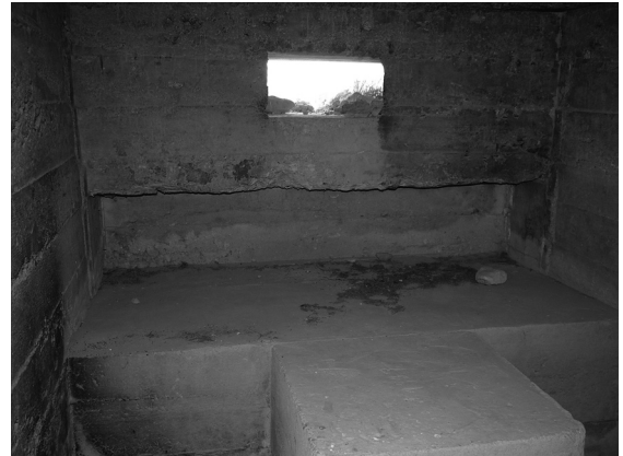
Vista del interior de una de las cámaras del Búnker 3, con la bancada para el armamento, la hornacina sobre ella, y la tronera de disparo.
