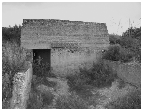
Acceso principal al búnker 1, en el que destaca la abertura de un patio delantero y la colocación en su fachada de un epígrafe.
