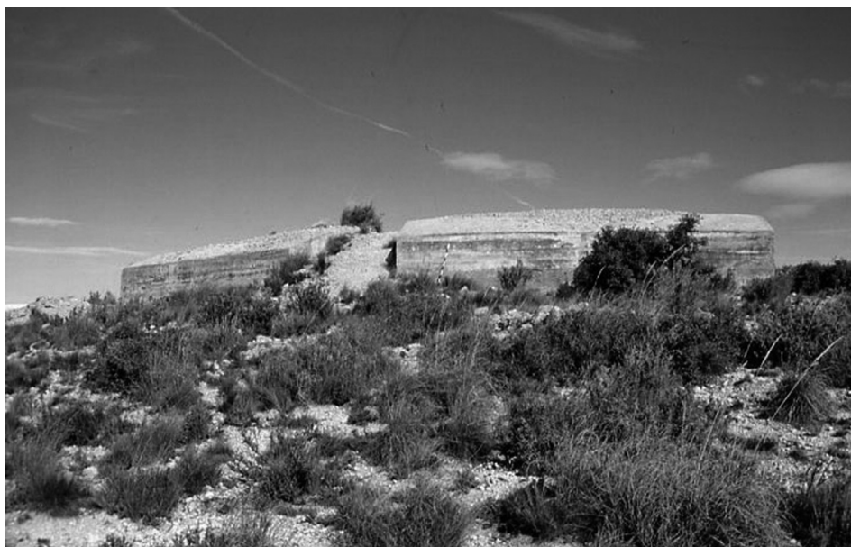
Búnkeres 18 y 19, en Sopaigón. La cubierta se soluciona, en este caso, mediante una bóveda.
