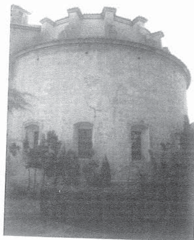
Las grietas verticales que aún se observan en el exterior pueden ser consecuencia del asentamiento del terreno. Foto: Juan R. Cañete.
