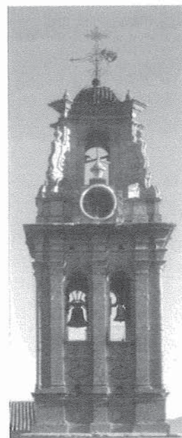
La torre de las campanas se levanta sobre la obra de sillería formando dos cuerpos barrocos fabricados de ladrillo. En su cana suroeste aún puede apreciarse el lugar donde estuvo emplazado el antiguo reloj de la villa. Foto: José F. Pereda Hernández.
