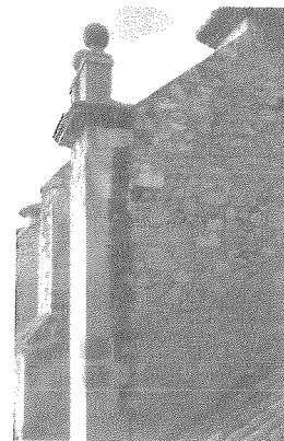
Contrafuerte de los pies de La Asunción.
