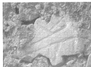
Dovela de arco gótico empleada como mate-rial de relleno, procedente de los sobrantes de talla o de las nervaduras de las bóvedas de la nave tras su hundimiento.
