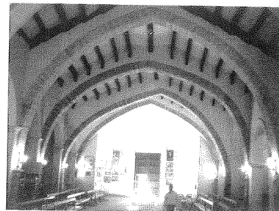
Interior de la iglesia de Santa María de Ayora (Valencia), donde se aprecian los arcos diafragmáticos.
