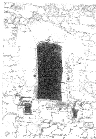
Vista exterior de la puerta de la fachada Este de la Torre del Homenaje, donde se aprecian los huecos para las vigas del puente de comunicación.
